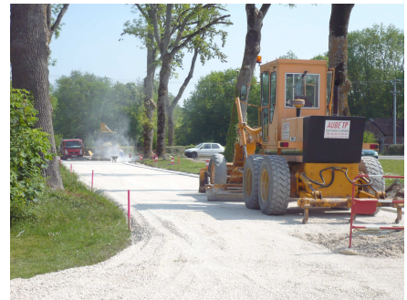
Aménagement de la Rue de la Gare.
