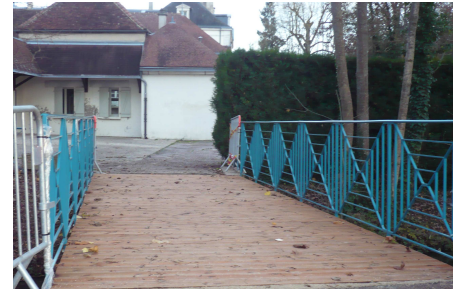
Changement du pont entre le parking et la Château Saint Louis
