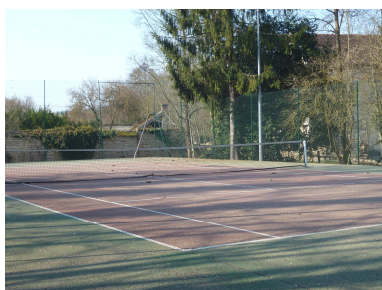
Réfection complète du grillage entourant le terrain de tennis
