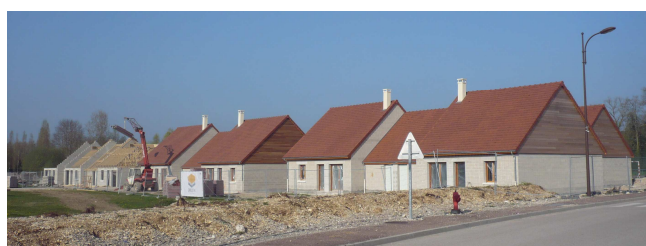
Avancée des travaux des logements seniors
