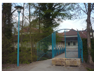
Installation de la grille à l'entrée du pont près du Château St Louis
