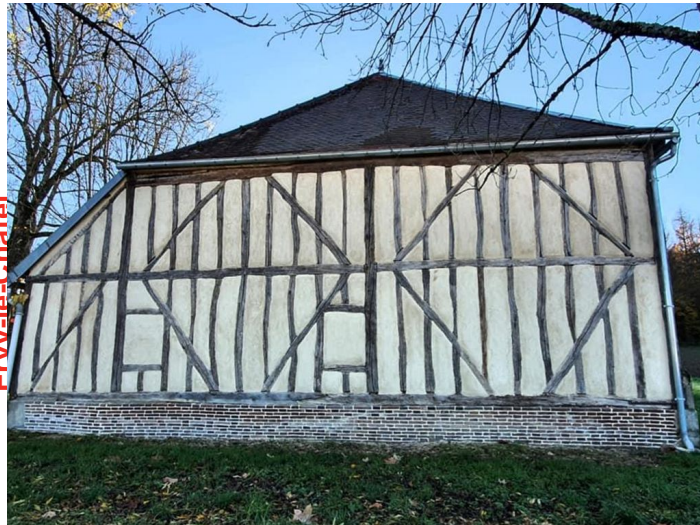
Photos avant et après-travaux – Grange à Ervy-le-Chatel
